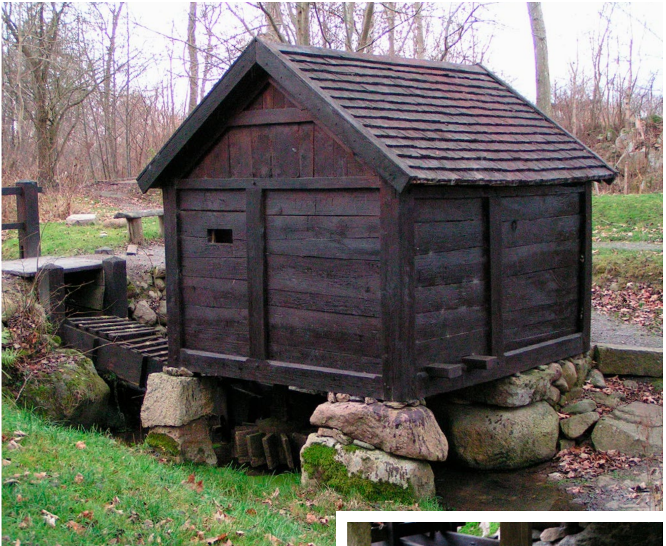
Middelaldercenterets rekonstruerede vandmølle med vandret skovhjul på en lodret aksel.
